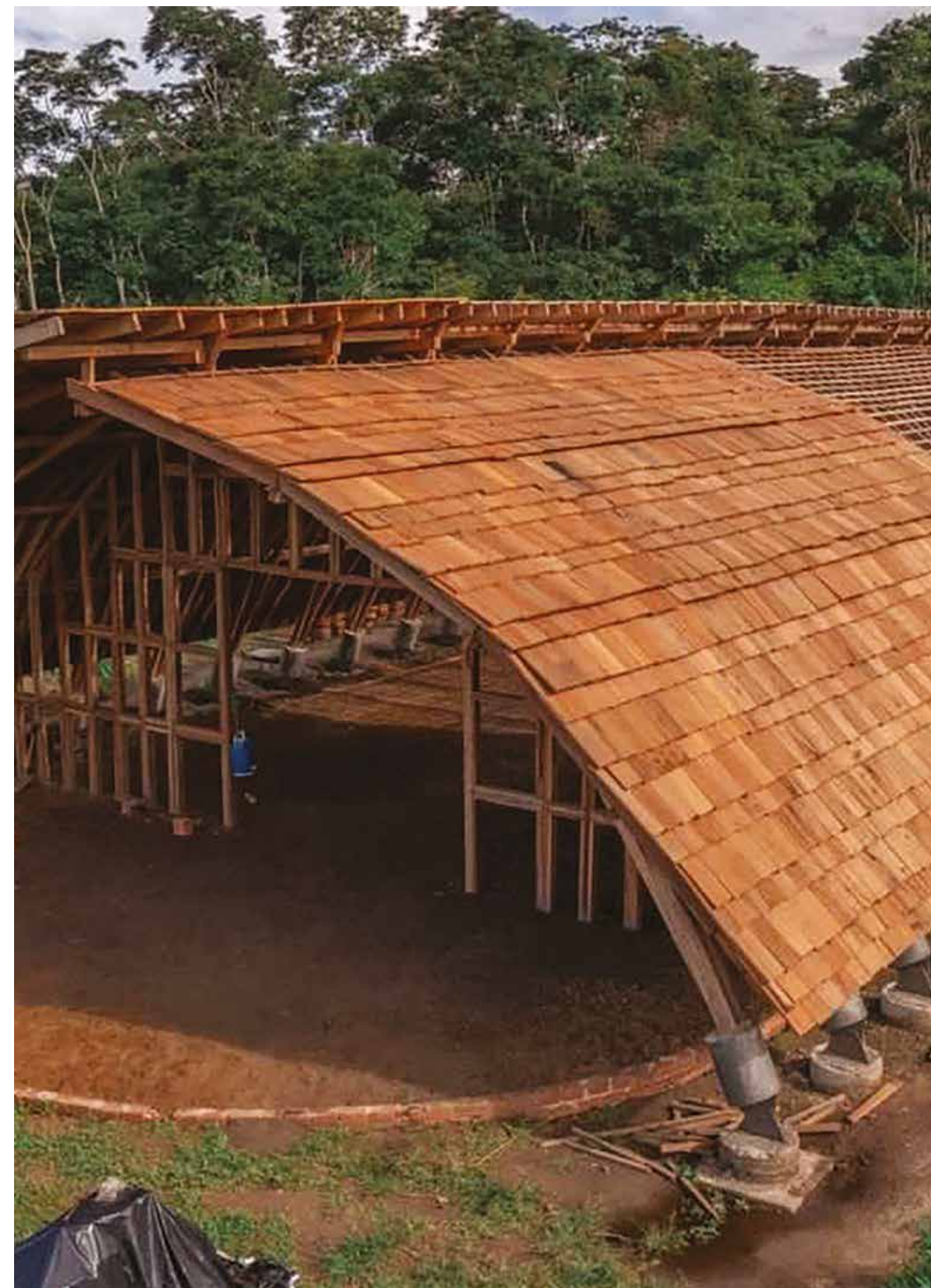
Centro de Mídia Uru-Eu-Wau-Wau, Rondônia, em construção — Acervo coletivo Casa Floresta.
