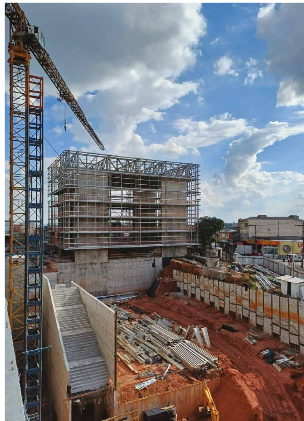
Construção do Quarteirão da Educação em Diadema, SP.
