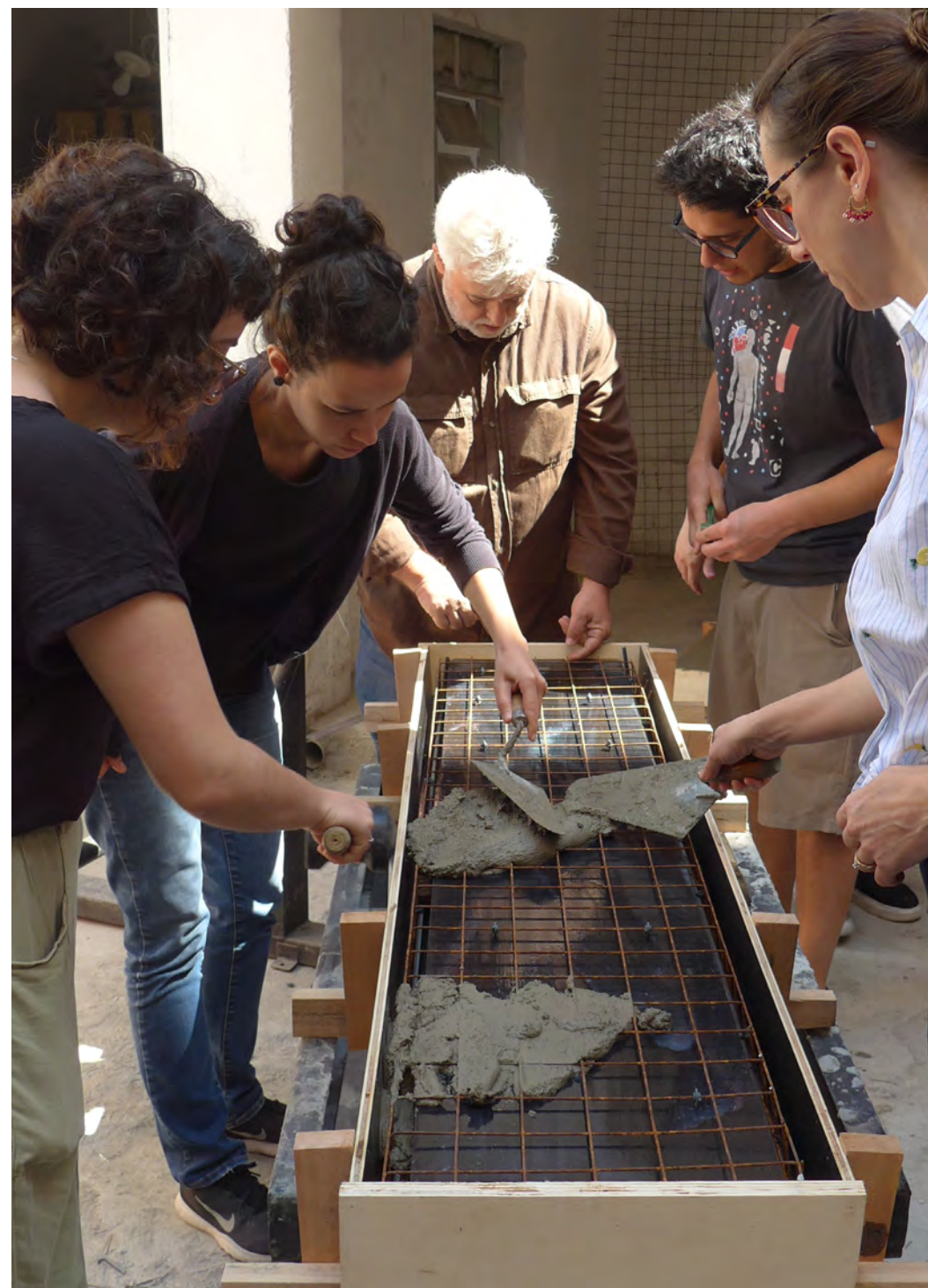
Concretagem na pós conceber e construir
