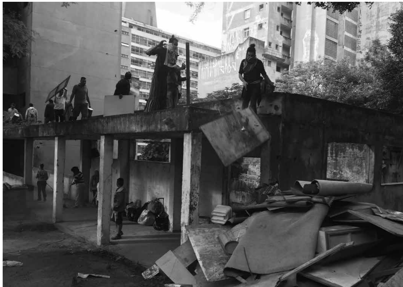
Ação de limpeza ao entrar no edifício
